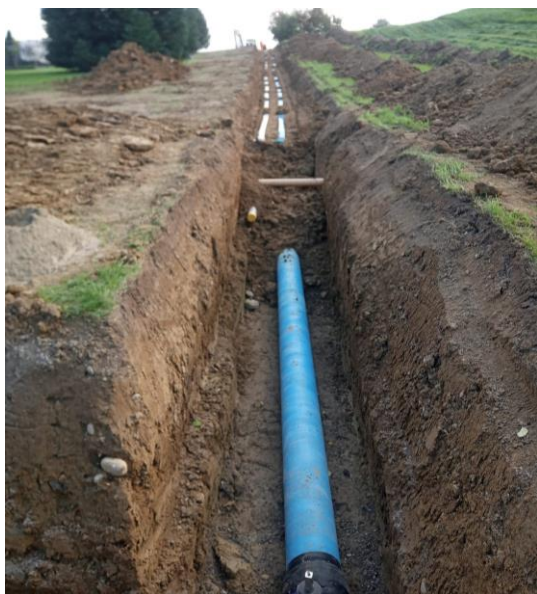
Einbau neue Leitung Agen - Rohrenmoos
